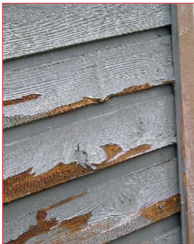
Рис. 2. Фотохимическое разложение алкидного покрытия (эмаль ПФ-115)
